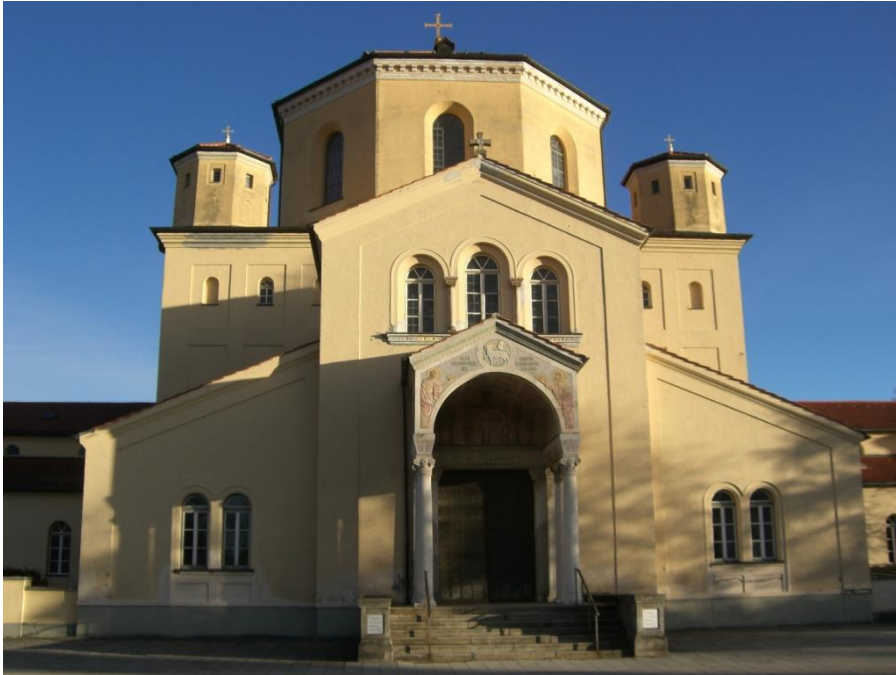
Abb. 13: Nordfriedhof: Aussegnungshalle nach Westen, 2012.
