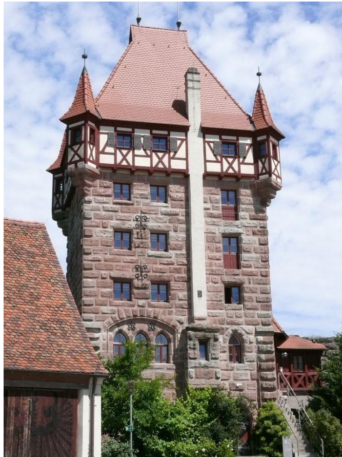
Der Schottenturm der Burg Abenberg
